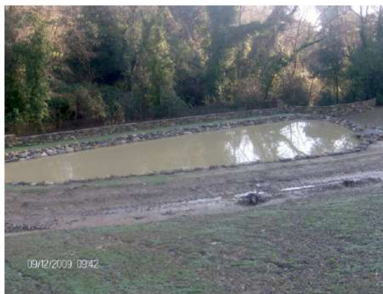
FOTO 4 - Vasca di laminazione a ridosso del Rio Saracino
