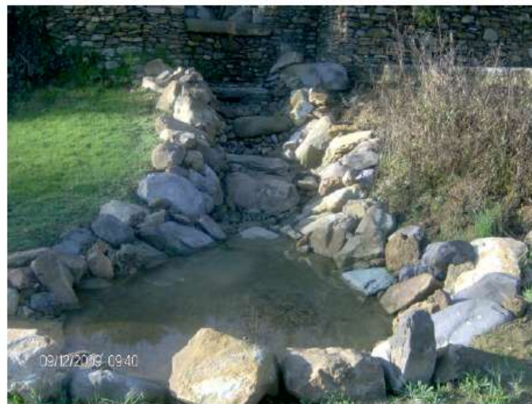
FOTO 2 - Briglia e vasca di decantazione a valle del fabbricato "A"
