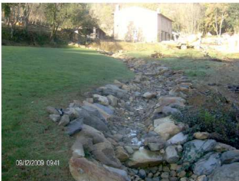
FOTO 3 - Panoramica parziale del fondovalle con canalsazione per la regimazione delle acque piovane
