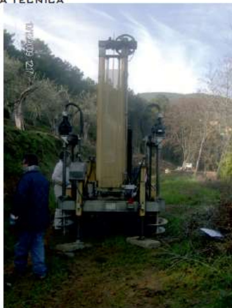
FOTO 5 - Terrazzo di imposta nuovo edificio
